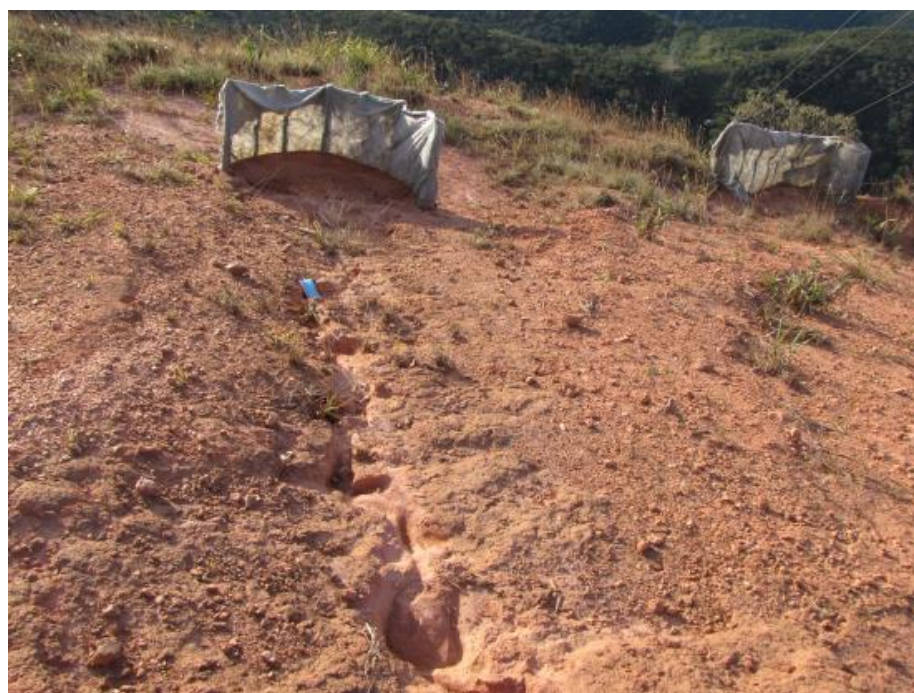
Figura 67 - Contenção de ravinamento em área de servidão de linha de transmissão de energia elétrica nas proximidades da comunidade rural de Duas Barras. Ponto 11. Itabira, MG.
